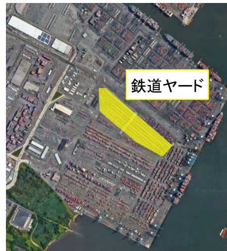
ニューヨーク港 (APM Terminal, Maher Terminal)
