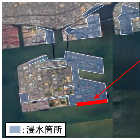
神戸港 六甲アイランドの被害状況
