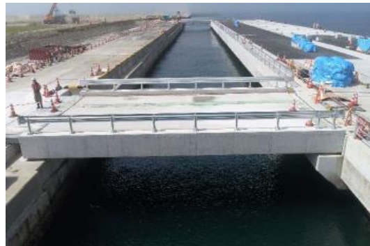
渡橋の架設状況
