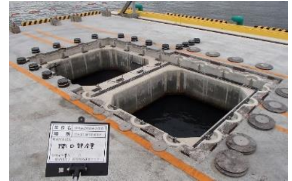
施工性確認試験実施状況(床版撤去)
