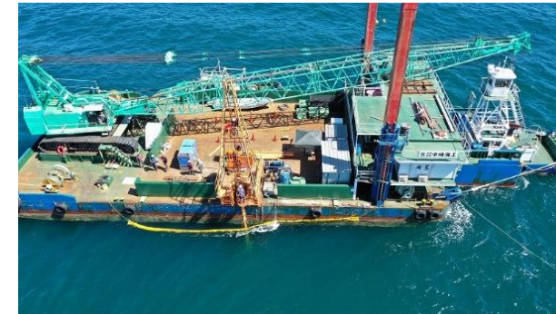
写真1 作業船 (標準貫入試験に使用)
