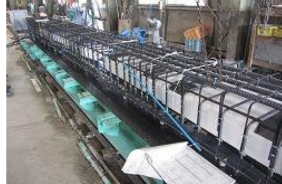
補強材組立状況
