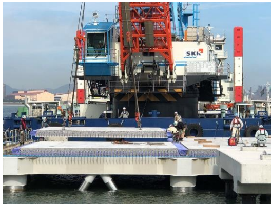
国土交通省施工実績写真 水島港
