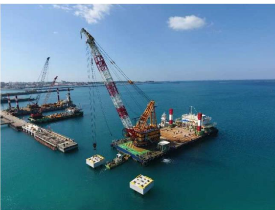
PCaブロック据付状況
