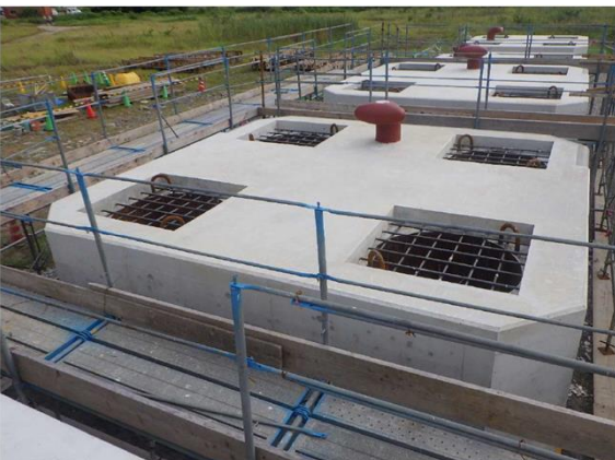
PCaブロック製作状況
