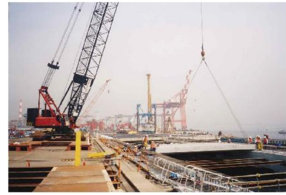
PCホロ一桁架設状況
