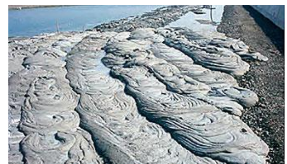
写真2 護岸背面捨石表面への施工状況
