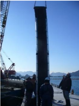
図3 挿入状況写真
