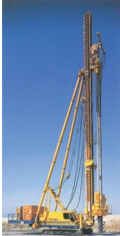
CI-CMC-HA工法施工機
