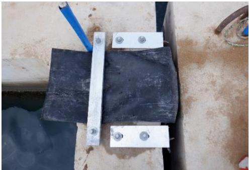
図2 設置完了写真
