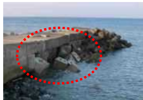
(コンクリートブロックの抜出し)
