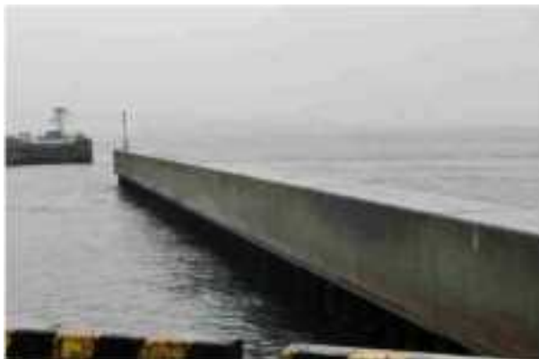
（陸上目視の点検状況）
