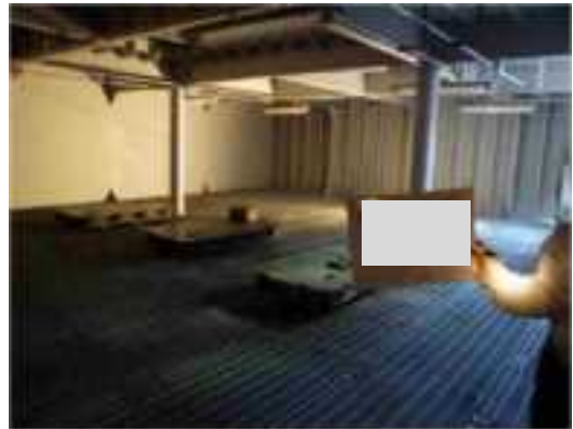
写真 3-5.1 ポンツーン内部
