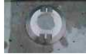
写真 3-3.1 電位測定端子
