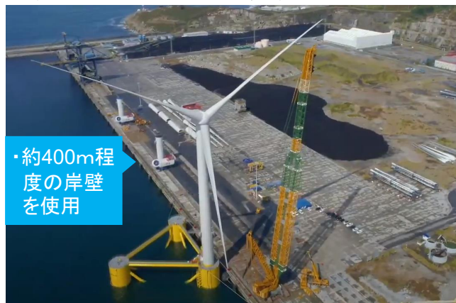
□ウインドフロート アトランティック (スペイン フェロル港)
