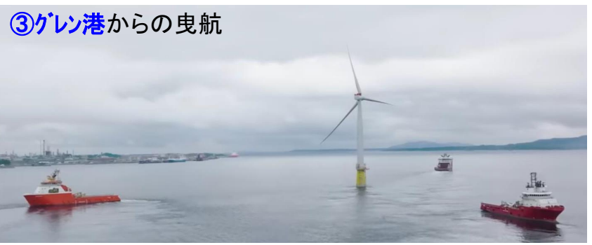
・アッセンブリ後、グレン港から沖合140kmのハイウィンドタンペンサイトまで曳航、設置 ・設置場所の水深は260~300m
