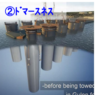
・ドマースネスにてコンクリートスリップフォーム工法にて完成(長さ107m)
