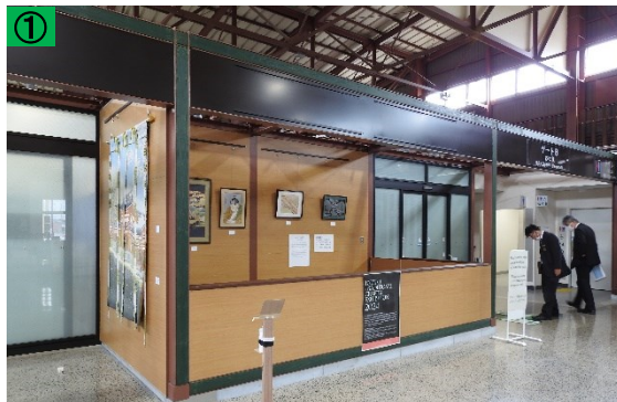
➤ 既設カウンターの状況
