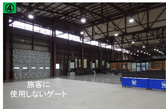
➤ ターミナル内部の状況
