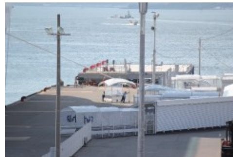
図ー可動式通路と固定式シェルター(博多港)
