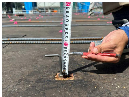
アンカーボルト詳細写真
