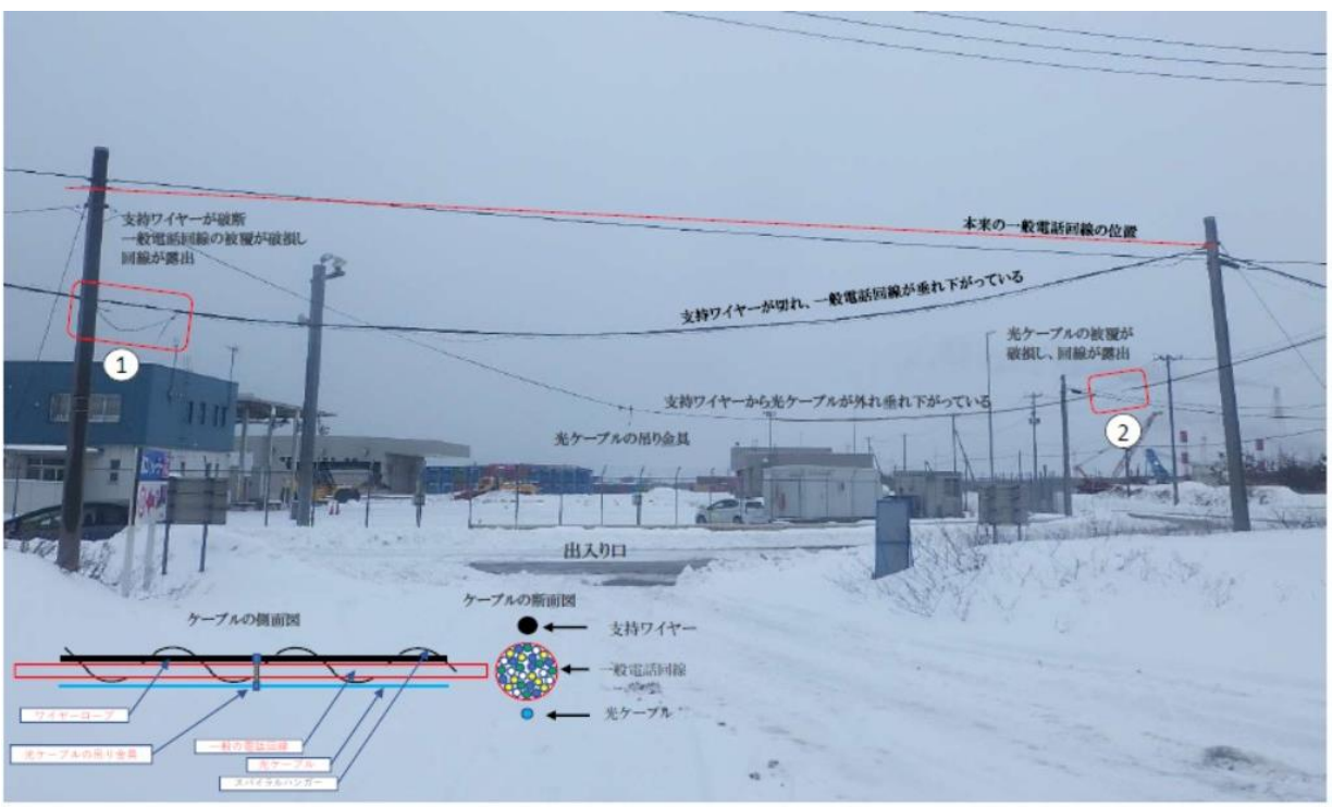
▽物損事故直後の全景写真
