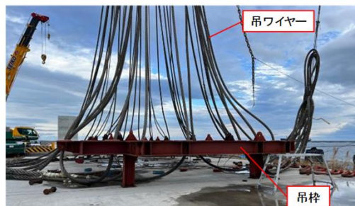
吊ワイヤーと吊枠の状況
