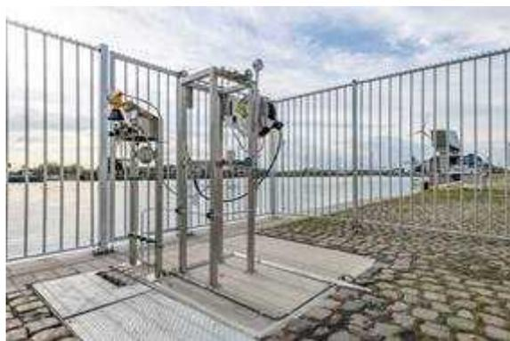
図 9: 水素ステーション(船舶用充填設備部分)
