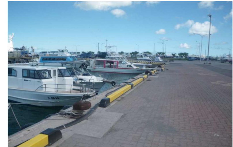
係船柱より陸側に車止めを配置
