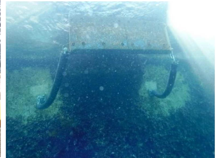
潜り込み対策(チェーン)付きの 受衝板付き防舷材の設置
