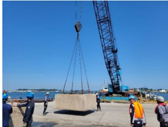
仮設係船柱の設置状況
