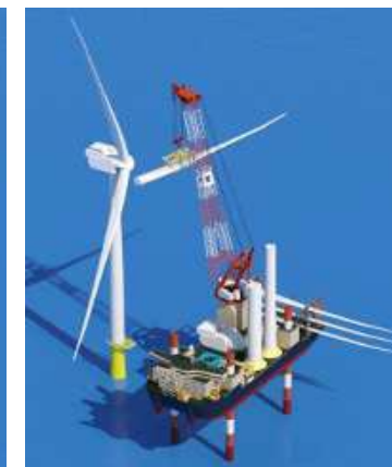
● ブレード取付
