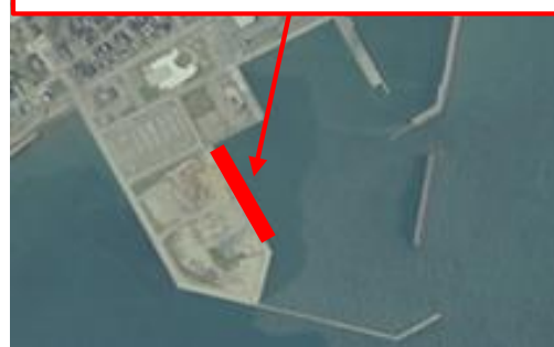
飯田港 岸壁(−4.5m)(応急復旧済)
