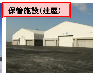
汚染土壌等保管施設
