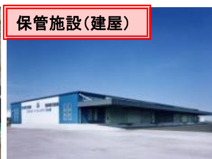
廃プラスチック等保管施設
