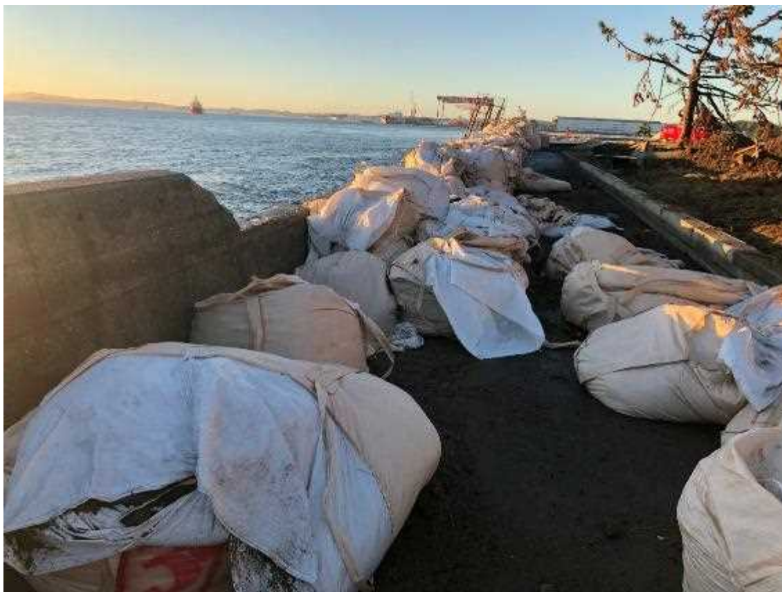
図－1 金沢区福浦地区 土嚢の飛散状況
