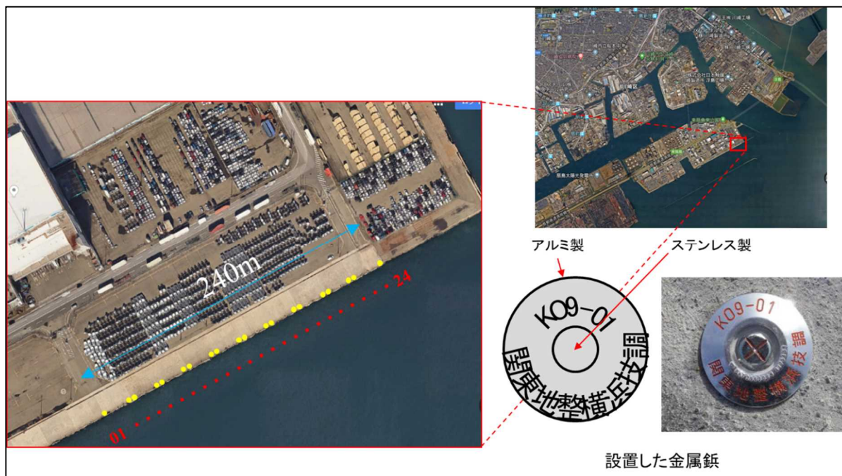
(事例) 川崎港東扇島地区 (-12m) 9号岸壁に鋏設置
