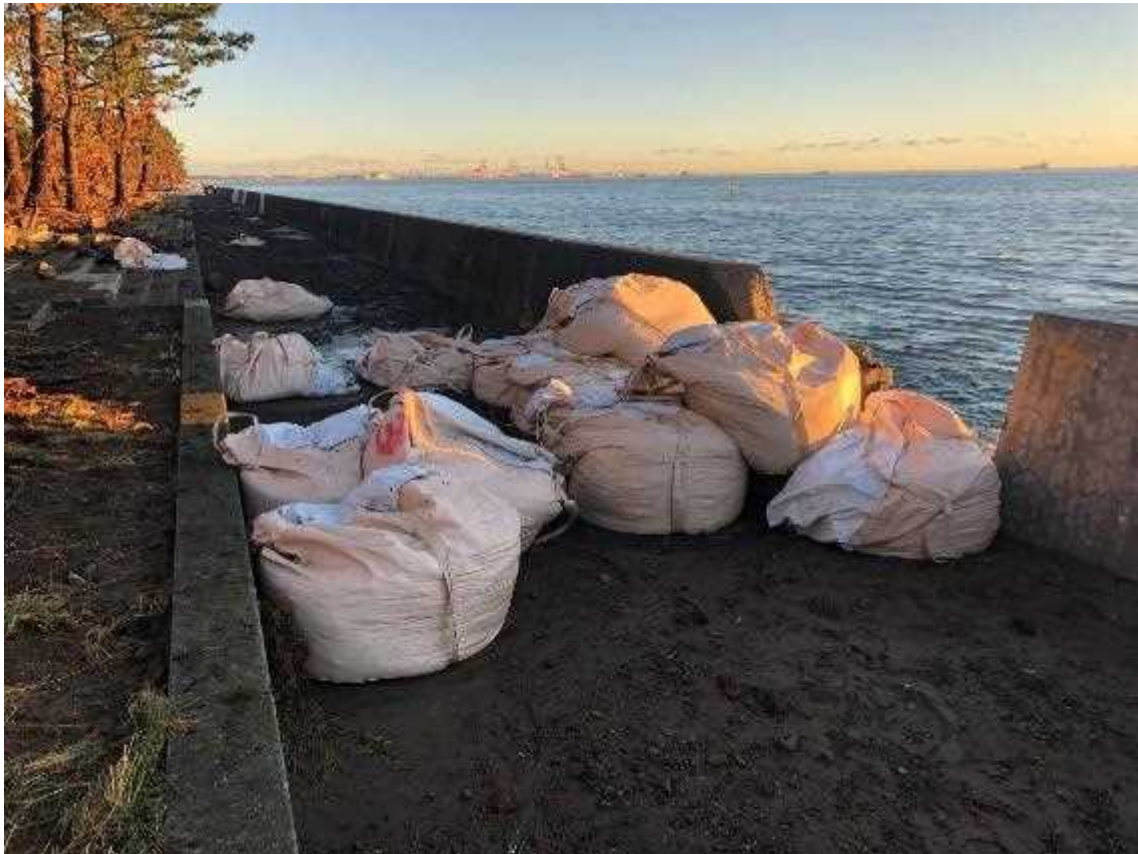
図－２ 金沢区福浦地区土嚢の飛散状況
