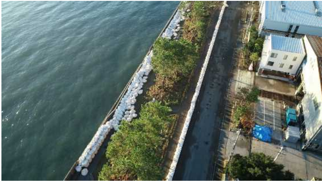
図ー 6 金沢区福浦地区 パラペットの土嚢は飛散したもの、背後の土嚢は飛散していない
