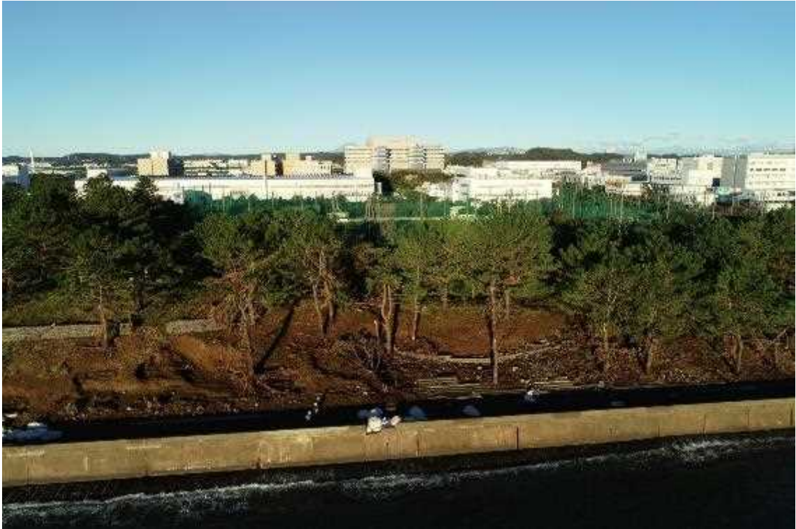
図－４ 金沢区福浦地区 築山付近
