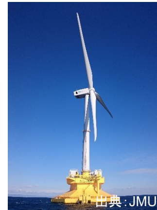
鋼製浮体の例 写真:「ふくしま浜風」
