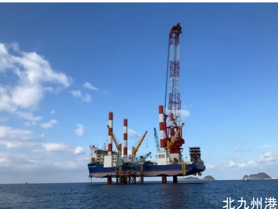
◆風車建設状況
