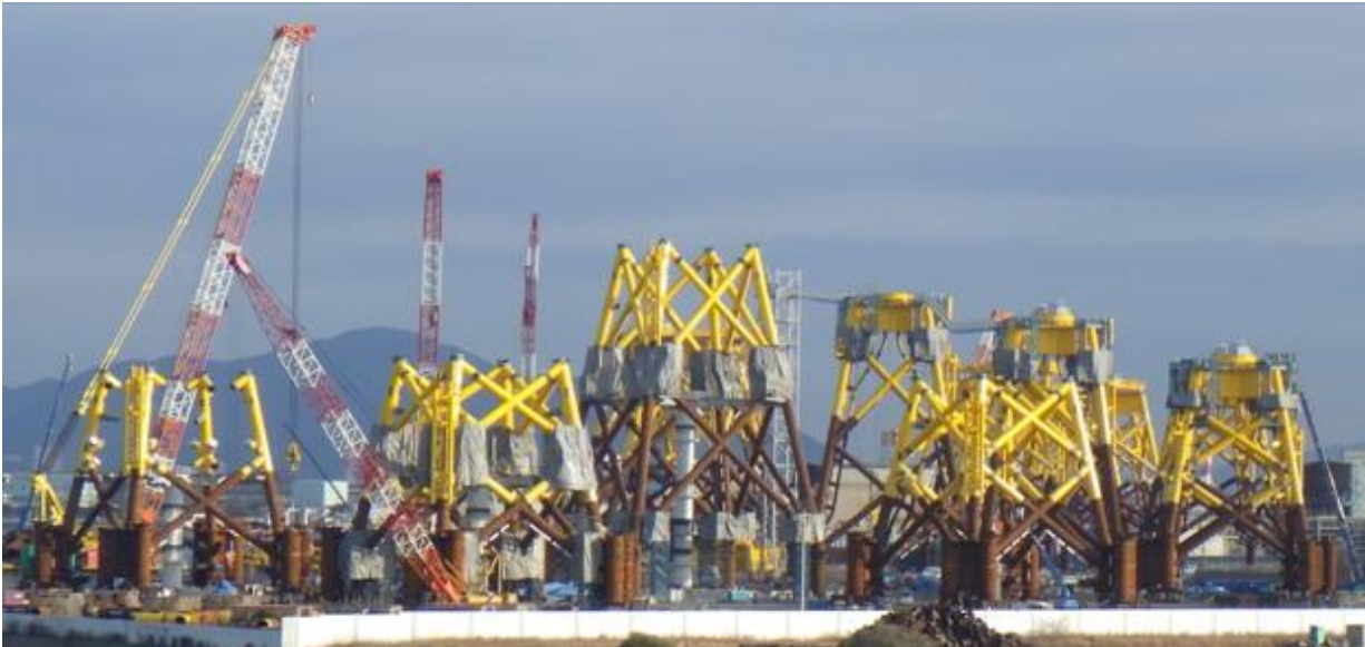
◆ジャケット式基礎の組立
