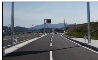
徳島小松島港 (臨港道路の整備)
