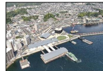
いつくしま 蔵島港 (浮桟橋等の整備)
