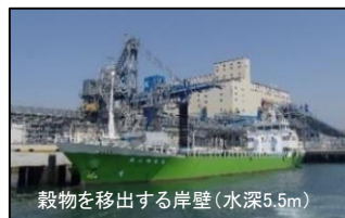
水島港 (岸壁の整備)
