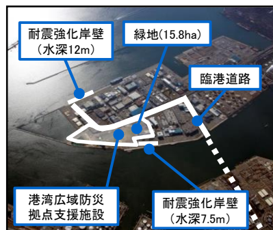
基幹的広域防災拠点（川崎港）
