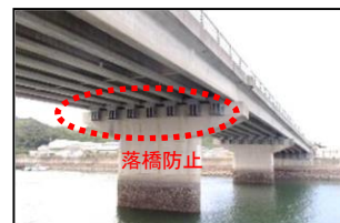
新居浜港 (橋梁の改良)
