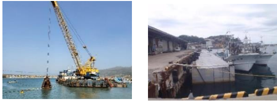
小型船だまりの浚渫作業の状況(R6.4) 移動が完了した漁船(R6.4)
