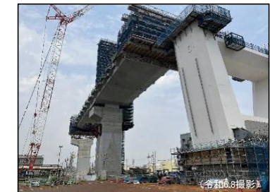
③ 橋脚MP5,6
