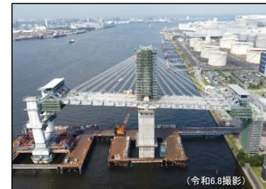
② 主橋梁部MP1～MP3
