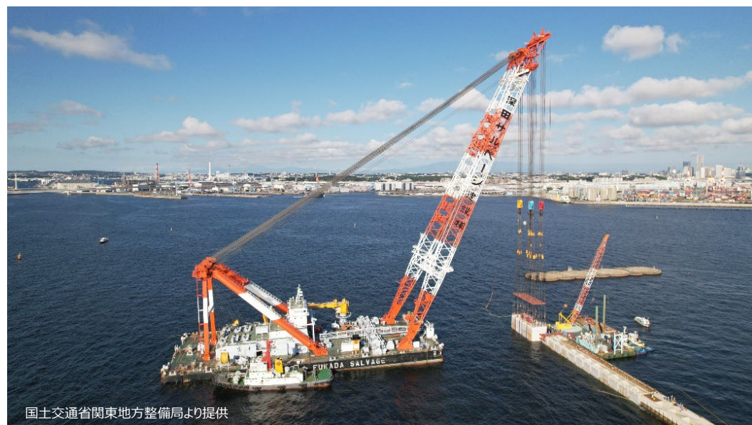
新本牧ふ頭の護岸構築状況（2024年9月）
