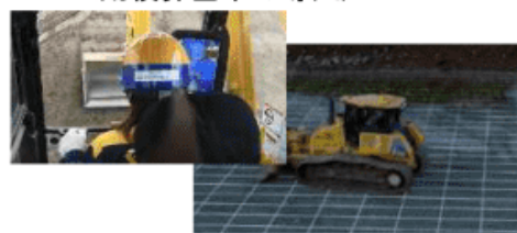
ICT建機による施工
