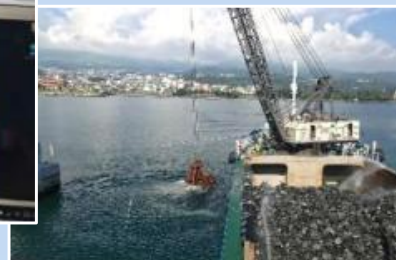
【ICT基礎工】捨石投入の可視化
