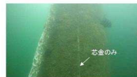
栈橋鋼管杭の陽極調査
