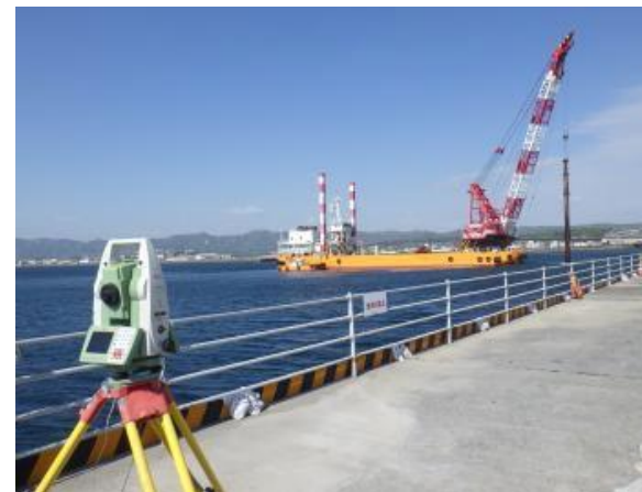
TSによる計測状況
