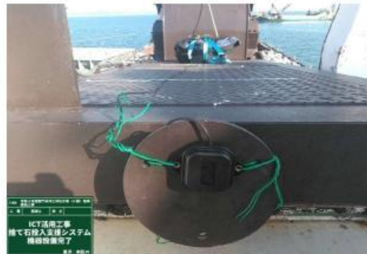
GNSS外部アンテナの固定
