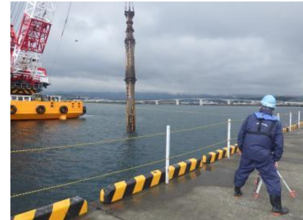
レベルによる高さ計測状況
