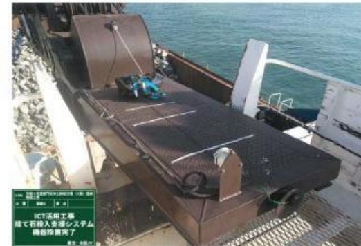
計測装置取付完了
