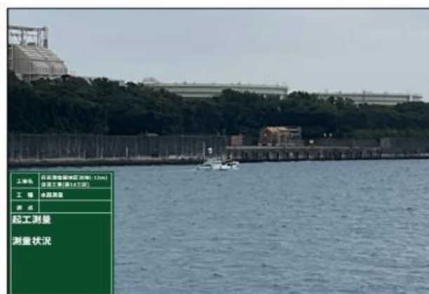
起工測量状況
