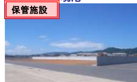
バラ貨物保管施設
