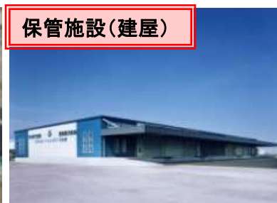
廃プラスチック等保管施設
