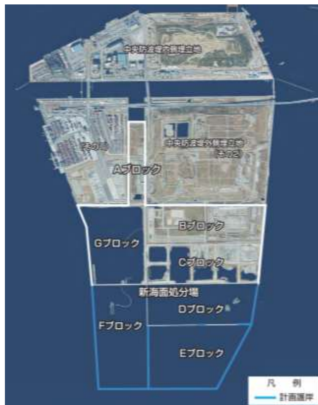
東京港海面処分場(出典:東京都HP)
