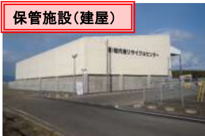
汚染土壌・石炭灰等保管施設
