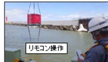
リモコン操作 遠隔吊荷制御装置による ブロックの向き調整
