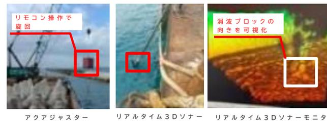
② ブロック据付システムによる消波ブロック据付位置の誘導
