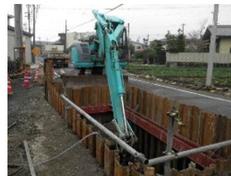
管路工事(掘削)
