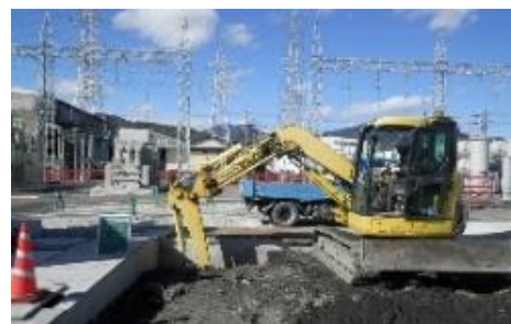
変圧器基礎工事
