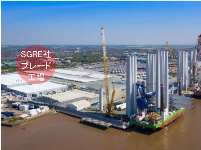
注: SGRE=Siemens Gamesa Renewable Energy(以下同様) 出所: greenporthullホームページ写真を基に作成
