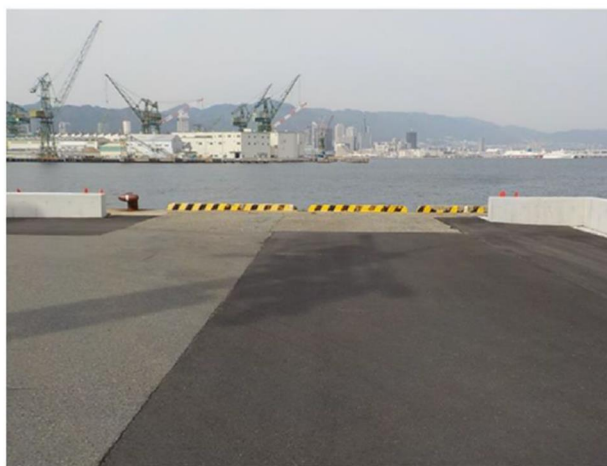
図 2-32 荷役のための部分的な開口部（神戸港事例）
