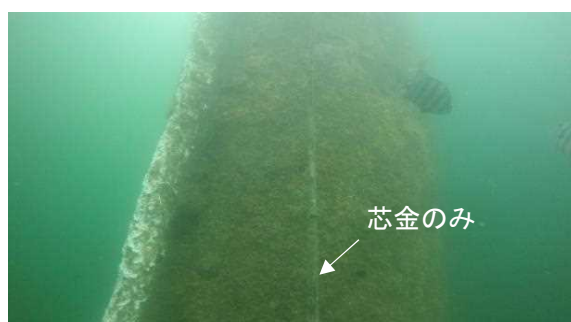
栈橋鋼管杭の陽極調査
