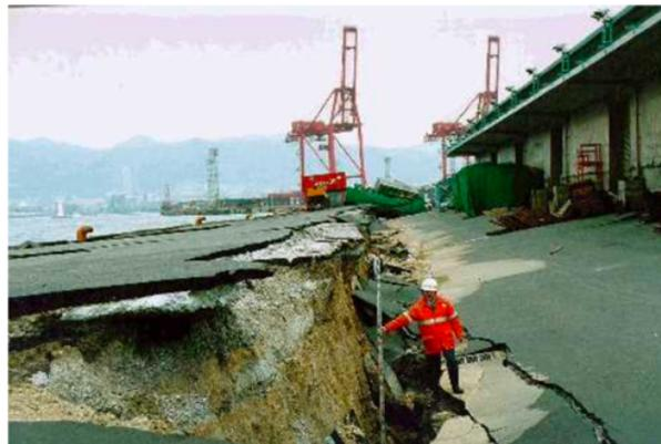
**図 5-3** 兵庫県南部地震における重力式係船岸の被災事例（写真は左右反転）（基準・同解説 p.1854）
