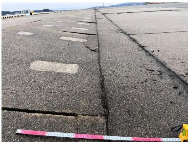
写真 4-3 コンクリート（渡版）の圧壊痕
