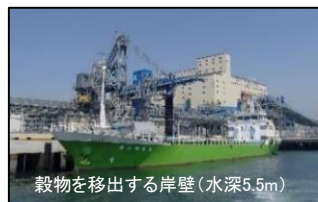
水島港 (岸壁の整備)
