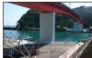
長島港 (橋梁の改良)
