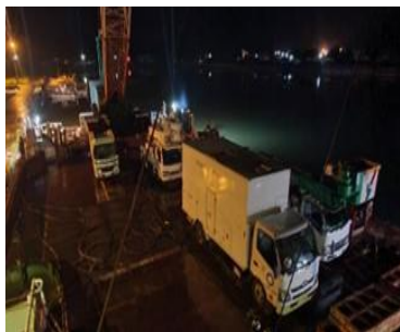
R5年6月奄美地方大雨時、花天漁港へ停電復旧に必要な作業車両を海上輸送 (鹿児島県篠川港)
