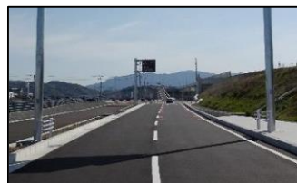
徳島小松島港 (臨港道路の整備)
