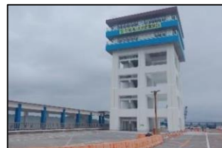
新島港 (津波避難施設の整備)
