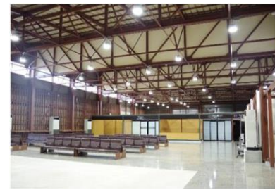
<旅客上屋等の改修：舞鶴港> (待合施設、空調設備、便所設備)
