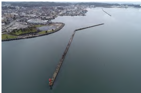
七尾港の被災状況調査(1/3)
