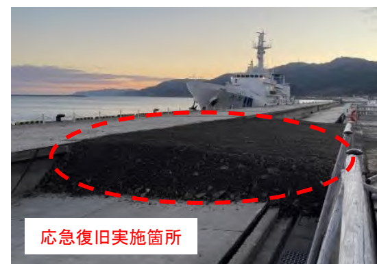
応急復旧の実施状況（1/5）
