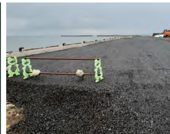
応急復旧の実施状況 (1/9)
