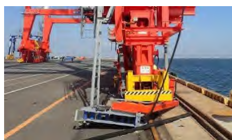
ガントリークレーンの損壊
