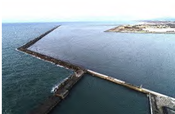
金沢港の被災状況調査(1/2)
