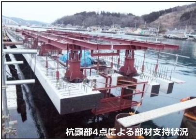
杭頭部4点による部材支持状況
