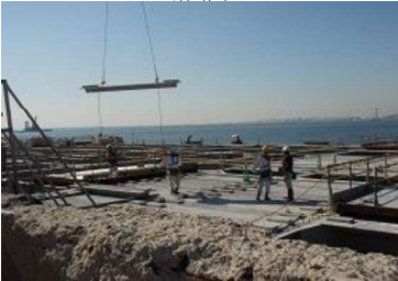
架設状況写真
