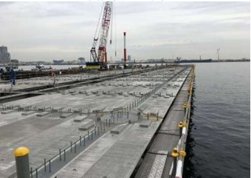
架設状況写真（2）
