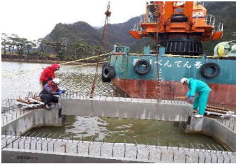
梁部材の据付・連結
