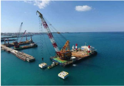
PCaブロック据付状況
