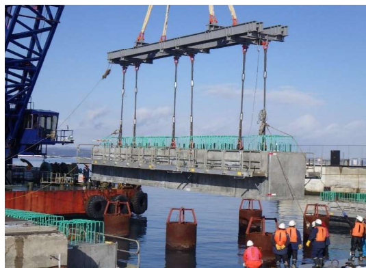
プレキャスト部材（受梁）の架設 3)
