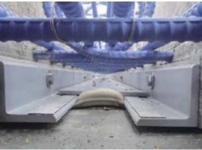
残存型枠設置
