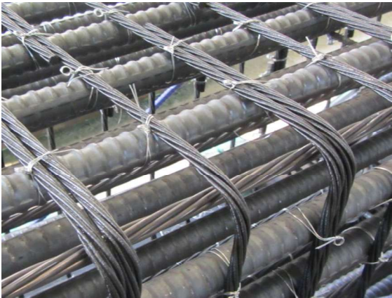
補強材組立状況（拡大）
