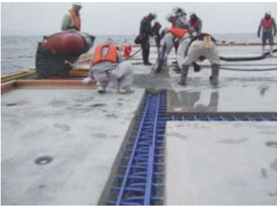
コンクリート打設
