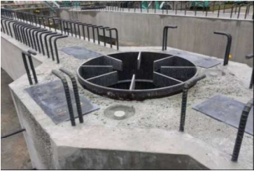
杭との接続部
