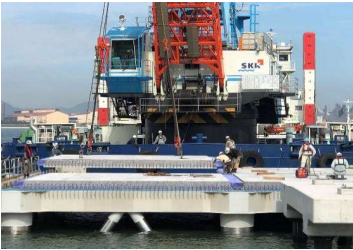
国土交通省施工実績写真 水島港
