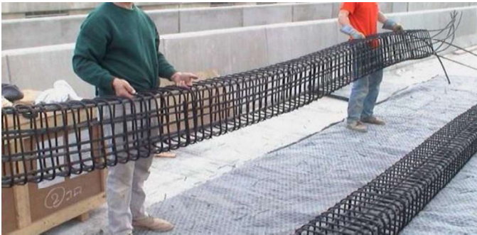
補強筋組立の例
