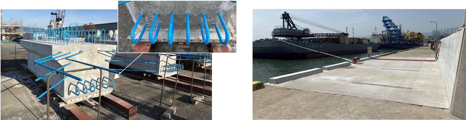
実証工事の状況(部材製作:左、完成:右)
