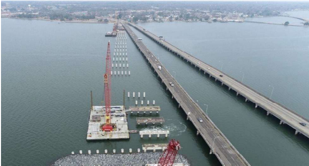
米国でのPCパイル施工例（CFCCをPC緊張材とスパイラル筋に採用）
