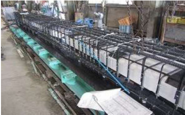
補強材組立状況
