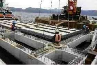
床版部材の据付
