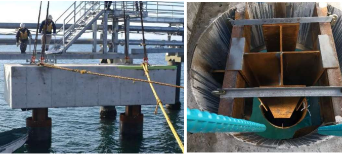
施工実績 1（ブロック据付状況）
