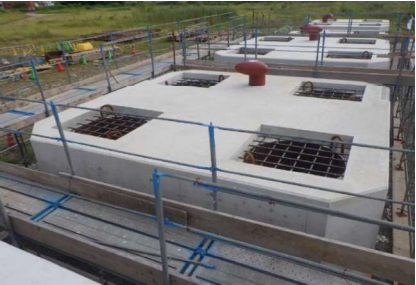
PCaブロック製作状況
