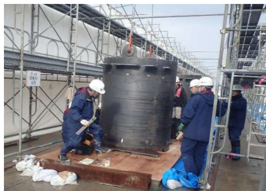
サイト製作時の鞘管設置 3)
