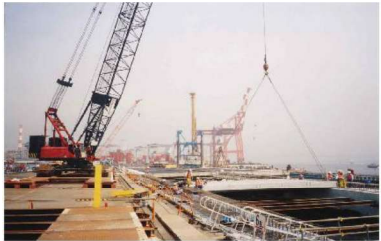
PCホロー桁架設状況
