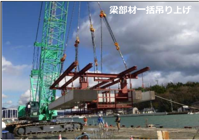
梁部材一括吊り上げ
