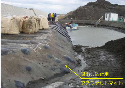
写真-3 敷設後の捨石の凹凸へのなじみ
