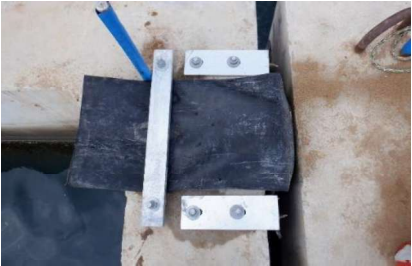
図2 設置完了写真
