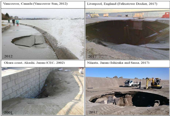
世界的に発生する陥没
