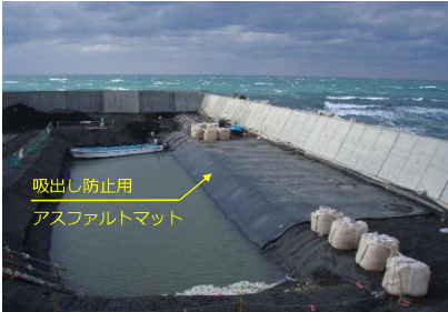
写真-2 護岸背後への敷設後の状況
