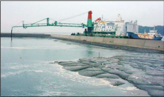
写真3 直接打設方式(水中打設)
