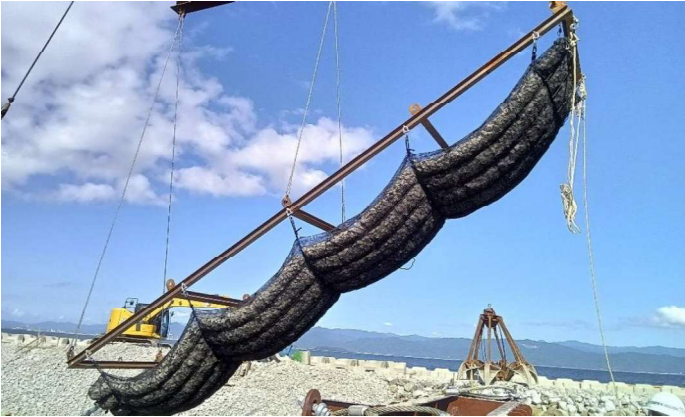
写真-3 GMの吊り上げ（水平吊り）状況
