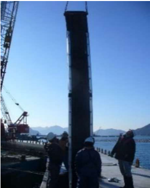
図3 挿入状況写真
