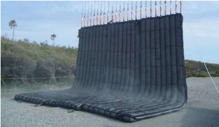
写真-2 GMの吊り上げ（縦吊り）状況
