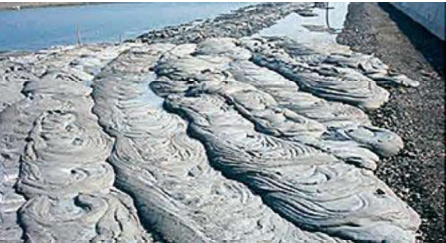
写真2 護岸背面捨石表面への施工状況
