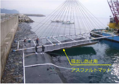
写真-1 護岸前面への敷設状況
