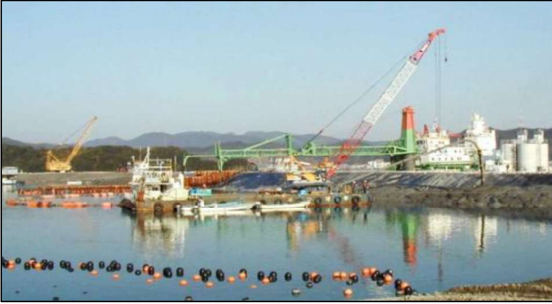
写真5 排砂管+打設台船方式による打設
