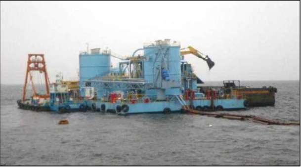
写真4 排砂管方式(圧送状況)
