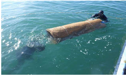
播種シートの小規模施工イメージ （小型船からダイバーに手渡し、 海底でダイバーが展張）
