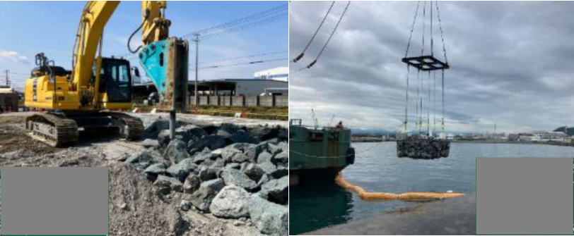
【カルシア人工石(破碎・据付状況例)】
