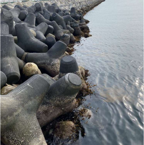
2017.3に設置した消波ブロック（8年経過した状況；2025.6現在の状況）
