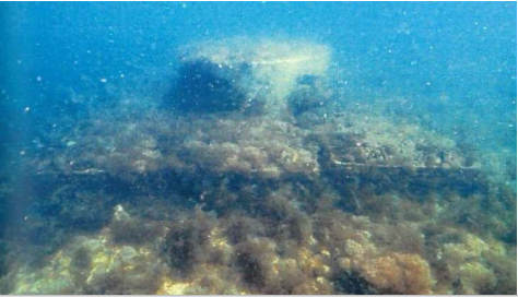
設置後6年後で藻が安定的に育成し、周辺へ拡散 長崎県
