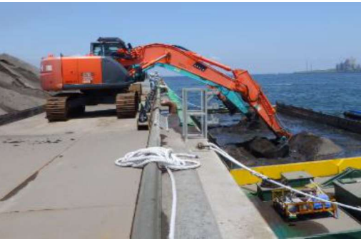
【カルシア改質土(混合状況例)】
