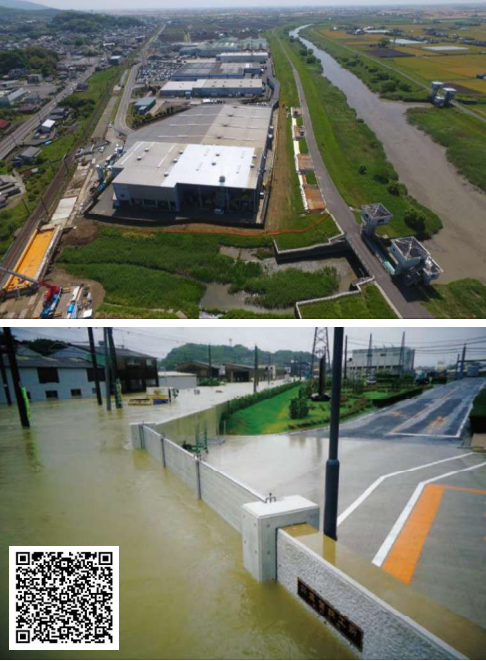
写真1,2 適用事例／河川近傍での高上げ・浸水対策
