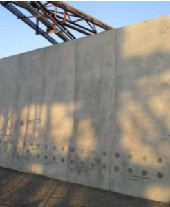
PCaジョイント壁(完成状況写真)
