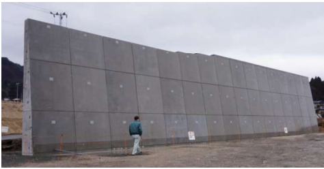
防潮堤に適用した大型ブロックの施工例 1ピース当たり20t程度の部材を組み合わせて 大型構造物を構築
