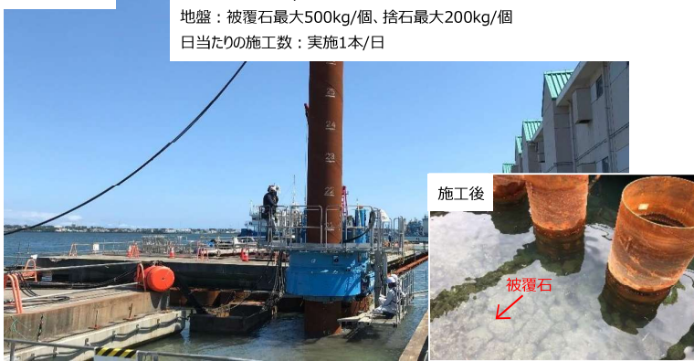
写真4 清水港日の出岸壁（-12m）（改良）工事
