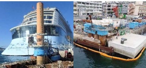
写真2 長崎湾（松が枝地区）岸壁（-12m）（改良）工事
