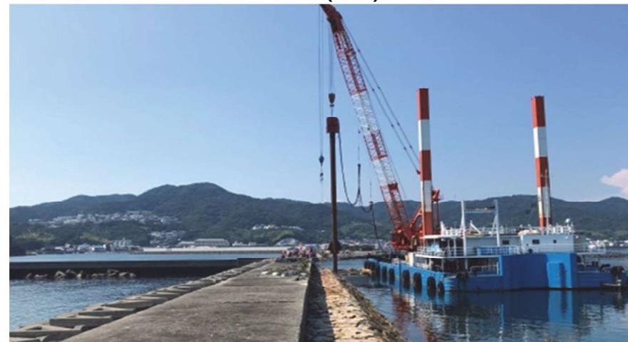
写真1 施工実績／兵庫県福良港2号離岸堤他改良(その1)工事 鋼管杭施工時の様子
