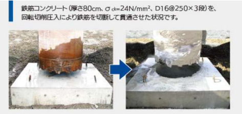
写真3 鉄筋コンクリートを切削した実証例
