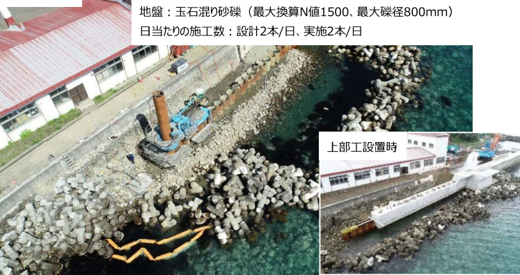
写真5 古平漁港海岸メンテナンス工事
