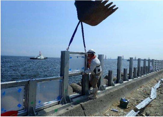
【パネルユニット落とし込み構造】
