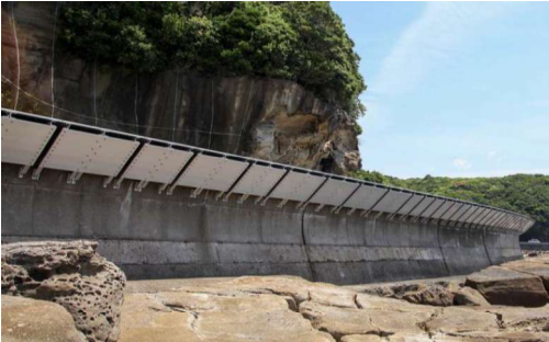
設置後写真(海側)
