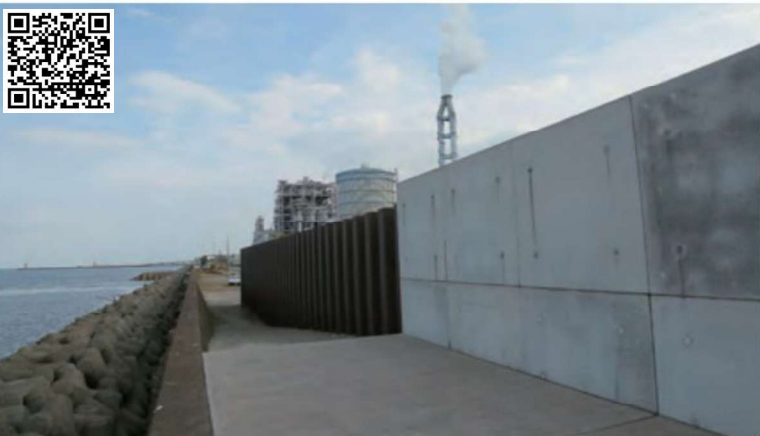
写真4 適用事例：大分港海岸(津留地区)護岸
