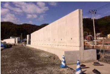
鋼管杭を基礎とするPCa防潮堤の施工例
