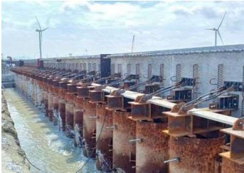
B部コンポジット版類似工事
