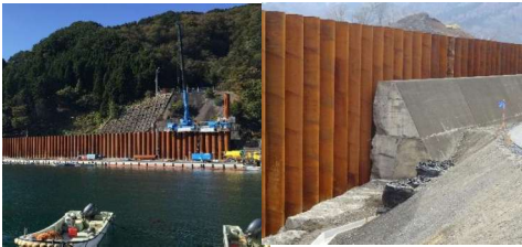
写真1 両石漁海岸災害復旧工事
