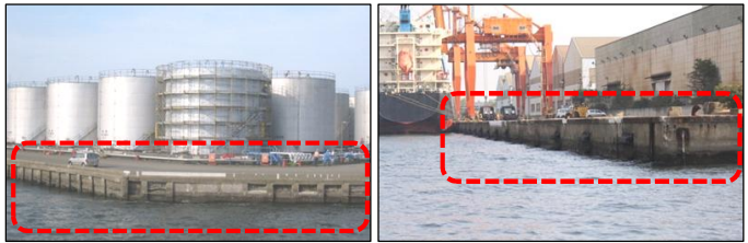
民有の護岸・岸壁の例
