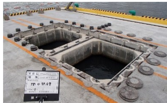
リプレイサブル栈橋の施工状況
