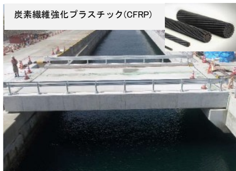
PC ホロー桁の施工状況 (右上：CFRP)
