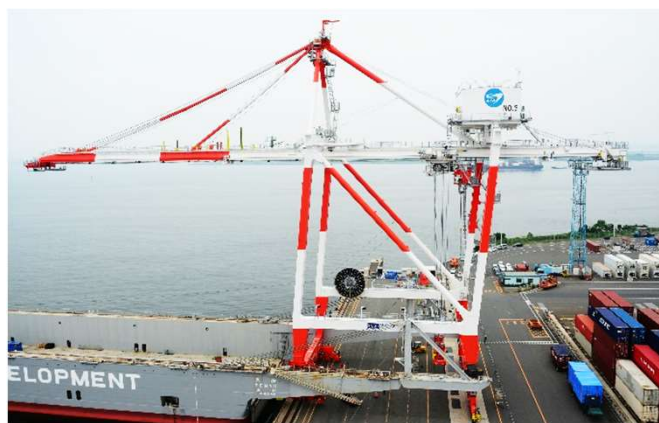
インバーター制御方式のガントリークレーンの導入 (T1岸壁に設置された新3号機)
