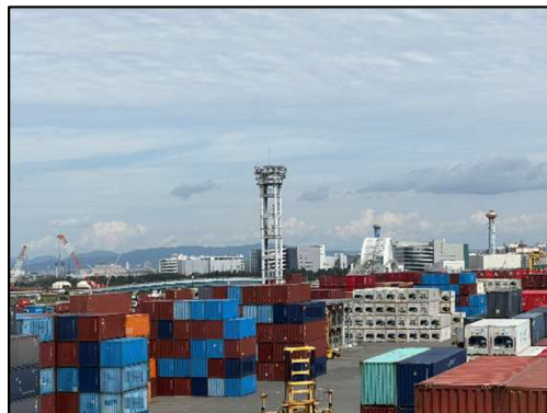
コンテナヤード内 照明塔のLED化
