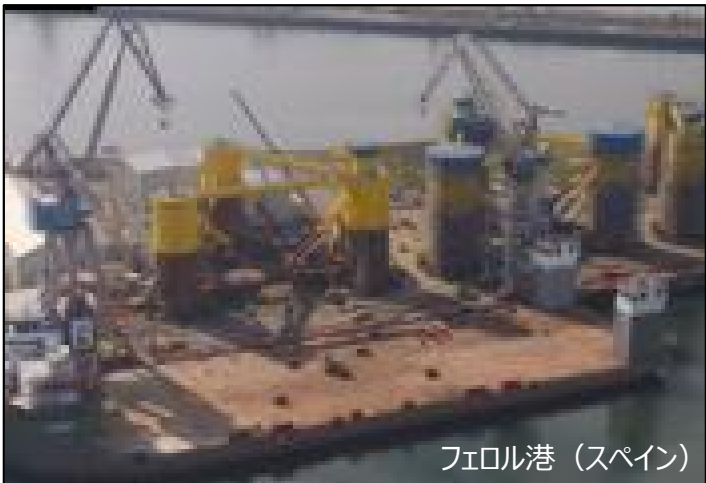
ヤードにおける浮体基礎製作の様子
