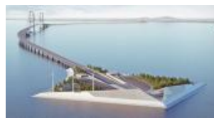
Shenzhong Link 沈埋トンネル
