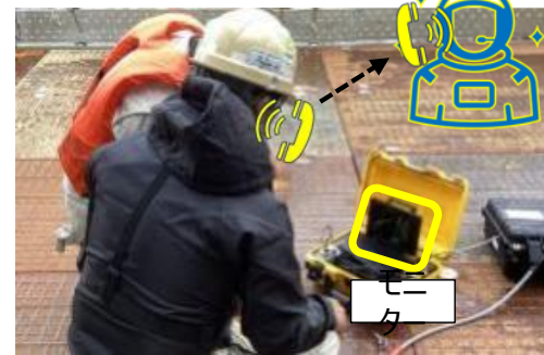
鋼管杭打設中の水中カメラによる確認状況
