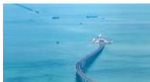
Hong Kong-Zhuhai-Macao Link 沈埋トンネル
