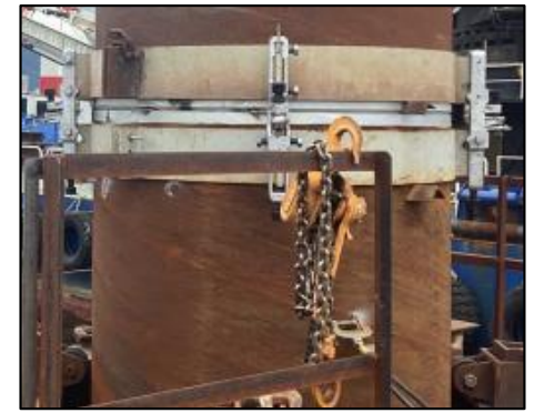
「建て方エース」実施状況
