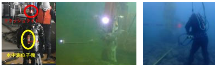
水中測位装置による潜水士位置関係の監視や、フラッシュライトによるバックホウ端部(旋回半径)の認識など、濁水中での安全管理方法を提案
