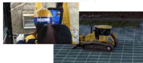
ICT建機による施工
