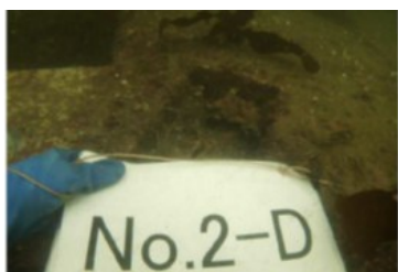
【既設吊鉄筋の腐食状況】
