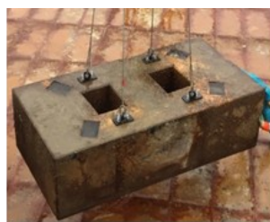
【吊金具を用いた撤去状況】
