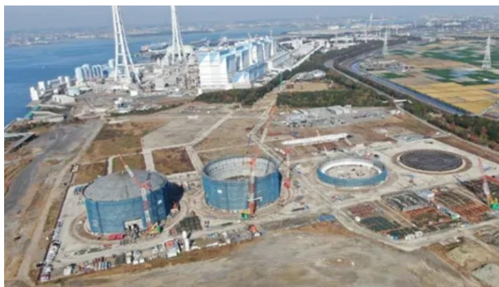
碧南火力発電所商用アンモニアタンク建設工事の様子 (2025年11月時点) 出典:(株)JERA
