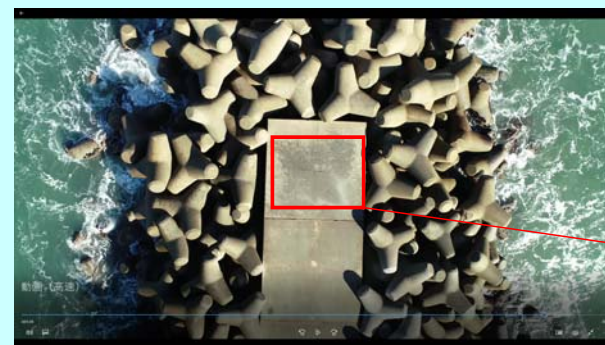
撮影事例(突堤) 変状確認
