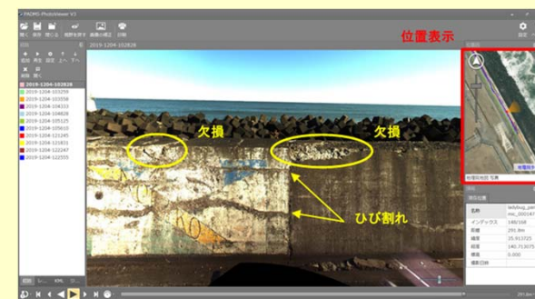
撮影事例(護岸胸壁) 変状の確認
