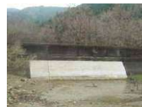
堤体前面に張りコンクリート
