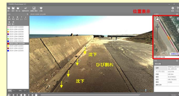
撮影事例(天端被覆工) 変状の確認
