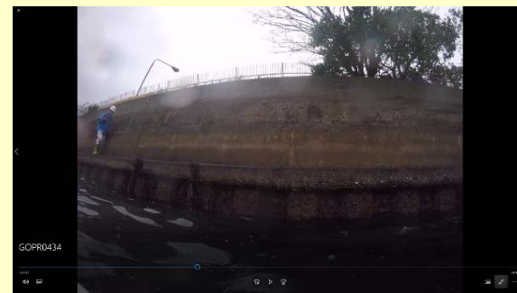
撮影事例(護岸) 変状確認
